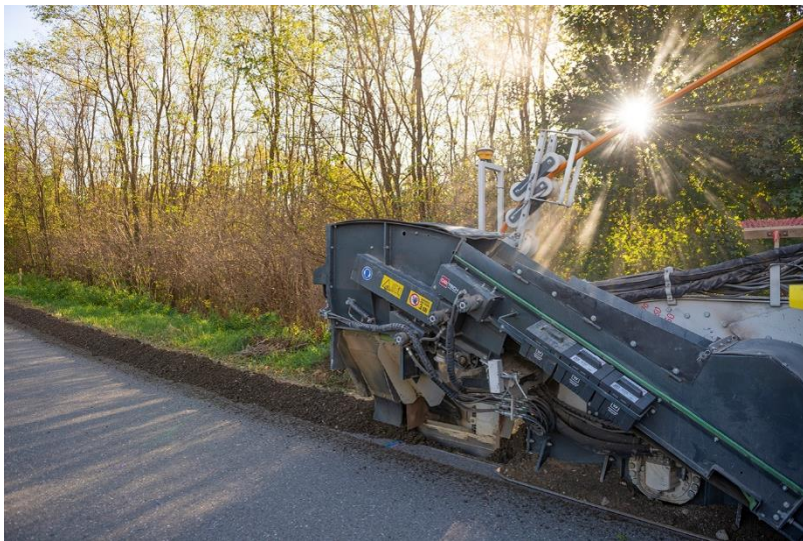
Abb. Schlitzgraben im Bankett (©Rossbacher, 2020)
